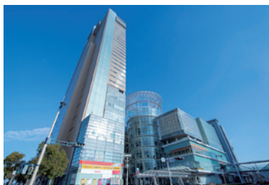
JR高松駅から徒歩約3分。高松港再開発地区に整備された複合商業施設サンポート高松のホール棟（写真右手ビル）2階で開業
